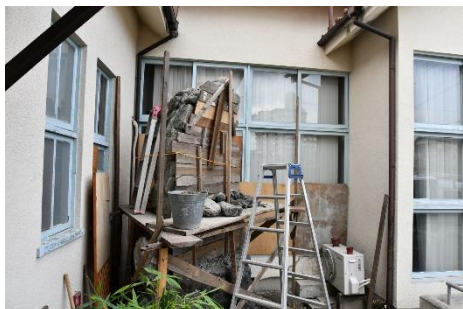
型枠養生中のグロット
